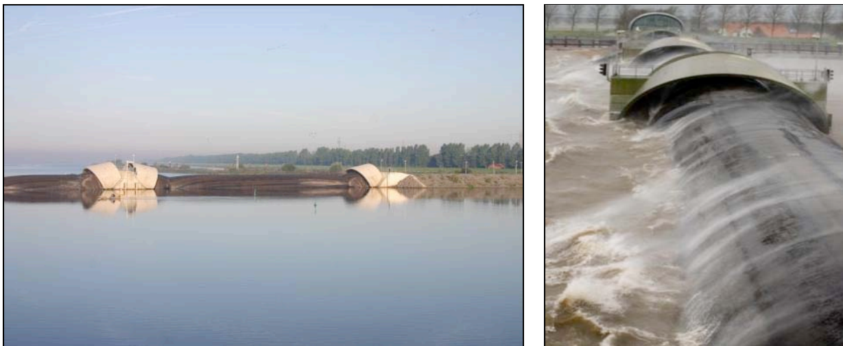
Abb. 3: Sturmflutsperrwerk Ramspol am IJsselmeer in den Niederlanden (DMC, 2011)
