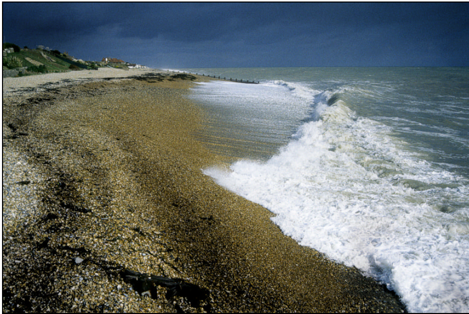
Vorgespülter Kiesstrand mit Buhnensystem vor Cliff End an der Südküste Englands
