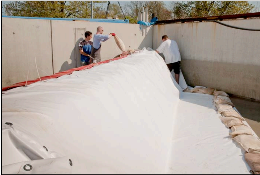
Abb. 9: Test mit wasserseitig vorgelegter Plane auf undurchlässigem Grund im Versuchsstand der TUHH beim Test von Konstruktionen im Kooperationsvorhaben HWS-Mobil im April 2011 (Foto: Koppe)
