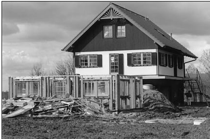
Abb. 21: Hochwassersichere Sanierung eines durch Überschwemmung geschädigten Neubaus bei Frankfurt/Oder
